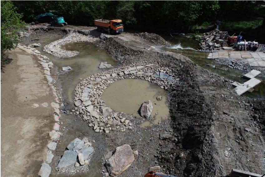
Abbildung 4 Schneckenbuhnen und Baustraße innerhalb der Spree, Spreeumleitung bauzeitlich *BauCom* (2024)
