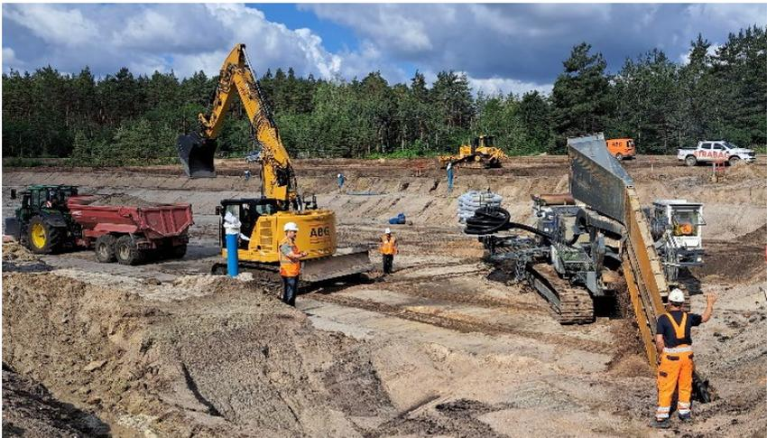
**Abbildung 4:** Einbau Horizontaldrainagen mit kombiniertem Fräsgerät als bauzeitliche Grundwasserabsenkung
