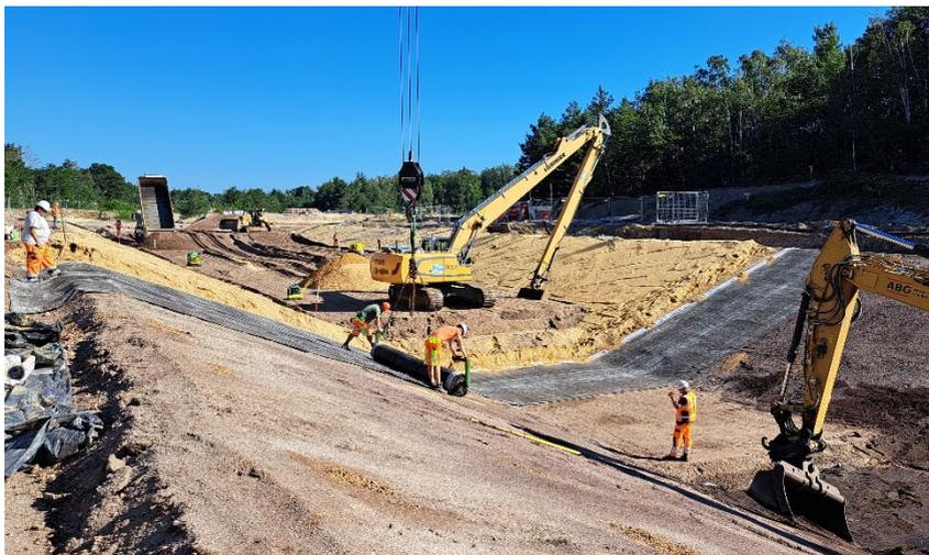
**Abbildung 5:** Einbau GTD mit Schutzschicht und Auffüllung
