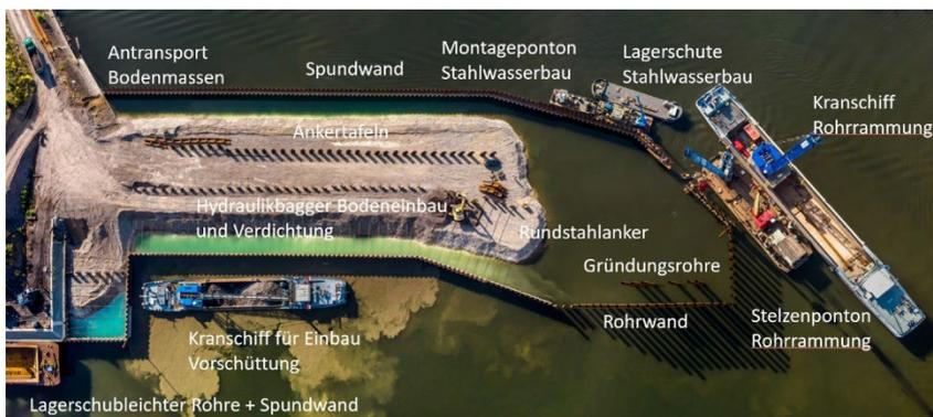
Abbildung 6: Übersicht zu den verschiedenen Gewerken und Tätigkeiten
