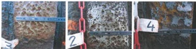
**Abbildung 1:** Im Jahr 2012 dokumentierte Korrosionsschäden an Spundwänden des äußeren Vorhafens der Schleusenanlage Niegripp nach Reinigung und Vorbereitung für US-Messungen (aus BAW (2012)).
