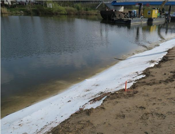
Abbildung 1: Neu eingebautes Geotextil in einer Bundeswasserstraße
