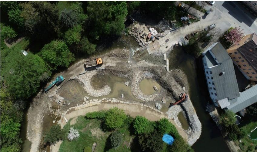
Abbildung 1 Drohnenvideo, Schneckenbuhnen im Bau an der Spree in Bautzen *BauCom* (2024)
