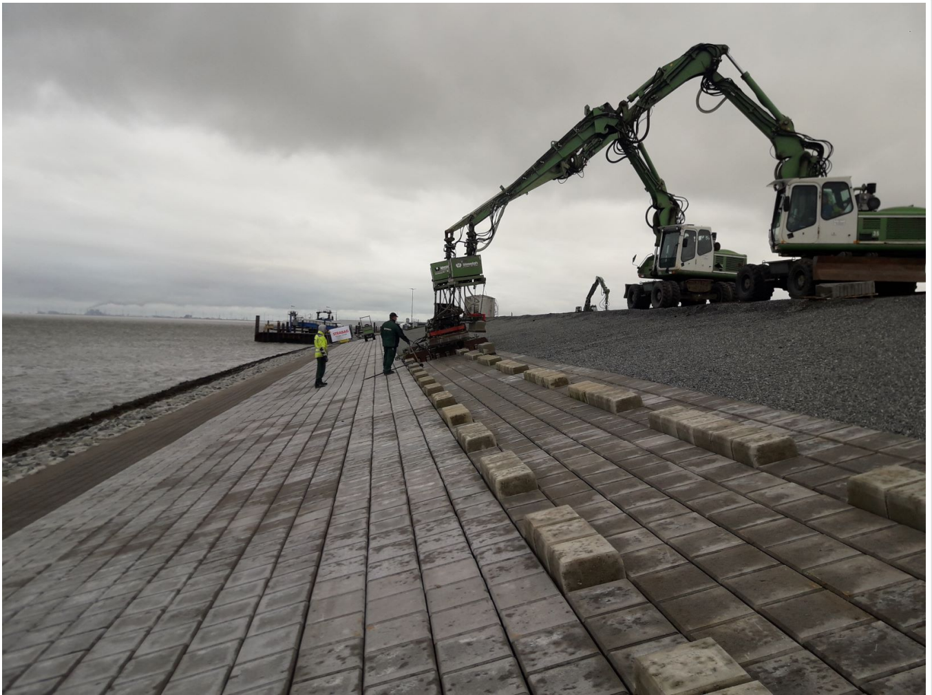
Verlegung des seeseitigen Deckwerks
